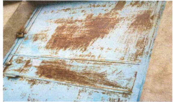
2: SUSTITUCION DE PUERTA
