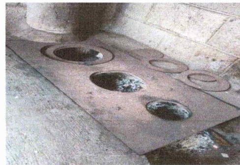
FOTO 6: PLANCHA Y CHIMENEA CON DETERIORO OXIDADOS.
